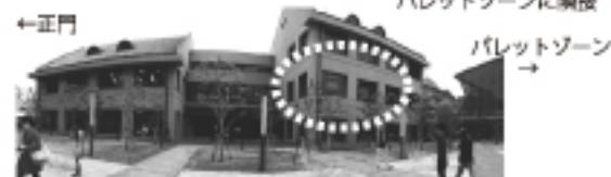
2号館教室棟2階
